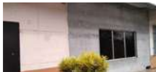
Construcción de la Cafetería
