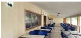
Reemplazo de cielo raso
