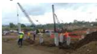
Construcción del nuevo centro regional universitario
