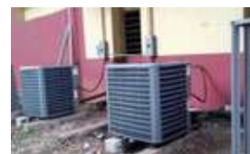
Instalación de condensadores de los acondicionadores de aire en la Escuela de Inglés
