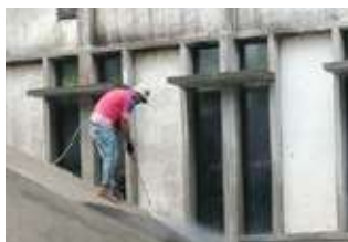
Limpieza del Edificio C
