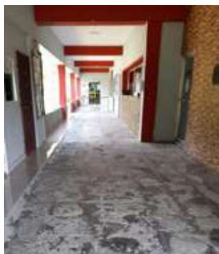
Revestimiento de paredes y piso en la planta del Edificio A
