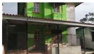
Remodelación de la entrada principal del centro
