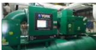
Mantenimiento al Chiller #2
