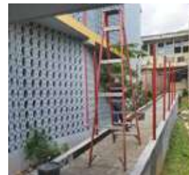
Rampa en construcción para uso del personal con discapacidad
