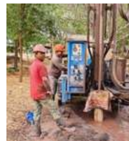
Construcción del pozo de agua
