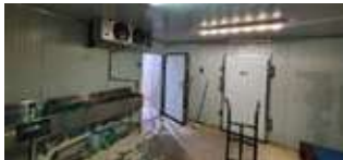
Remodelación de los cuartos fríos
