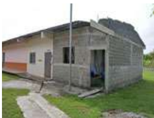
Avance de construcción de la oficina del Consultorio Jurídico del Centro Regional Universitario Panamá Este
