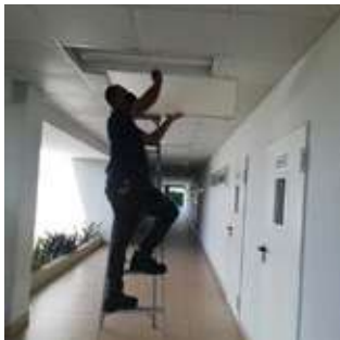
Reemplazo de las luminarias defectuosas de la Extensión Universitaria de Arraiján
