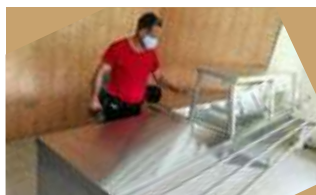
Instalación de baño María en la cafetería del centro regional
