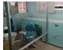
Instalación de mamparas acrílicas
