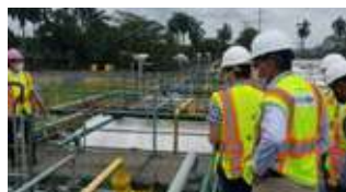
Inspección de planta de gas licuado
