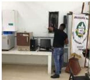
Reparación de líneas eléctricas
