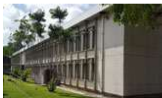
Limpieza de paredes del edificio A
