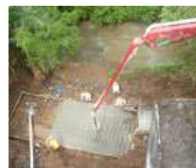
Reparación de tubería de 36", construcción de cabezal y muro perimetral
