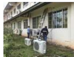
Mantenimiento a los aires acondicionados
