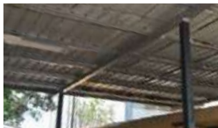
Cubiertas de zinc descartadas en otros proyectos que se les dió un segundo uso en Taller de Transporte
